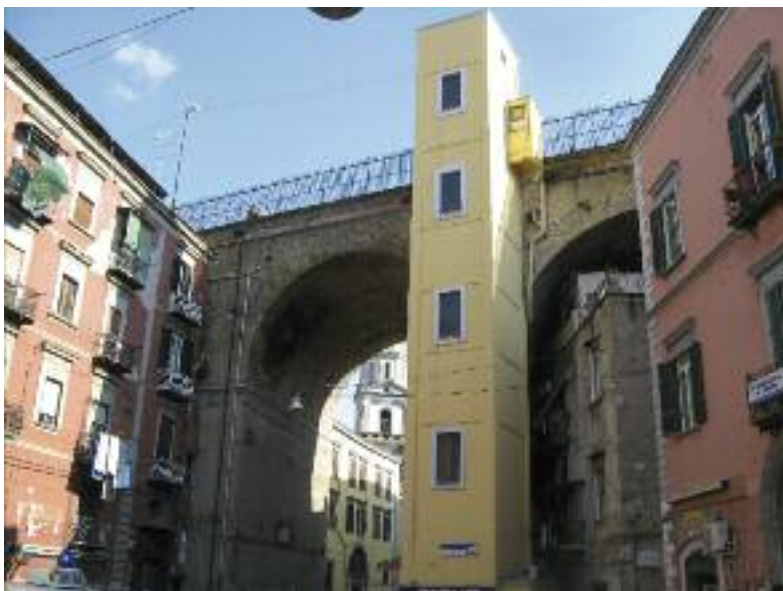
Ponte della Sanità
